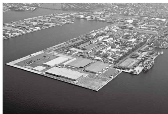
高松港朝日地区（右手がコンテナターミナル）
